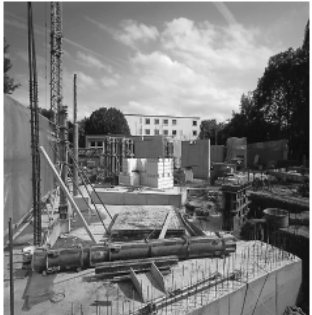
Erweiterung des Tagungshauses Stuttgart-Hohenheim Bilderserie zum Baufortschritt, Seite 67, 77, 103, 153
