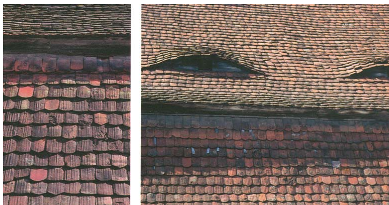
Abb. 1 und 2: historische Dacheindeckungen mit Handstrichbibern
