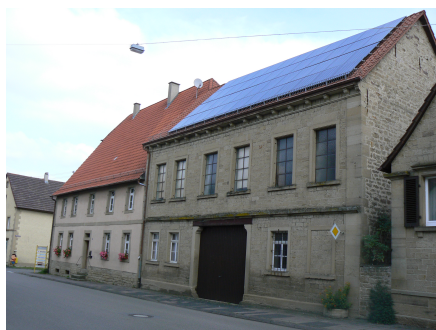
Abb. 3: Sichtbare Dachfläche aus PV-Modulen
